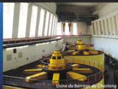
Usine du barrage de Chastang
